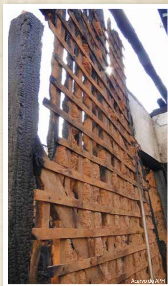
Detalhe da ruína do museu - e a parede de taipa exposta após o incêndio.
