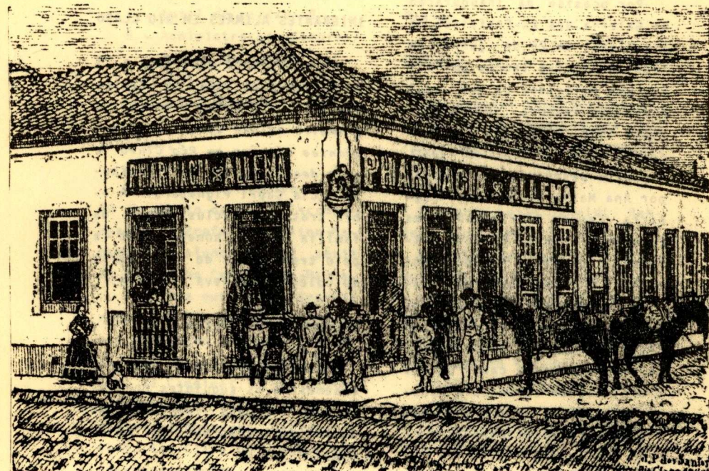
Edifício onde funcionaram a Câmara e a Cadeia de Rio Claro desde 1845 até 1876, ano em que sofreu reforma para transformar-se na "Pharmacia Allemã" (Rua Cinco, esquina da Avenida Dois).
